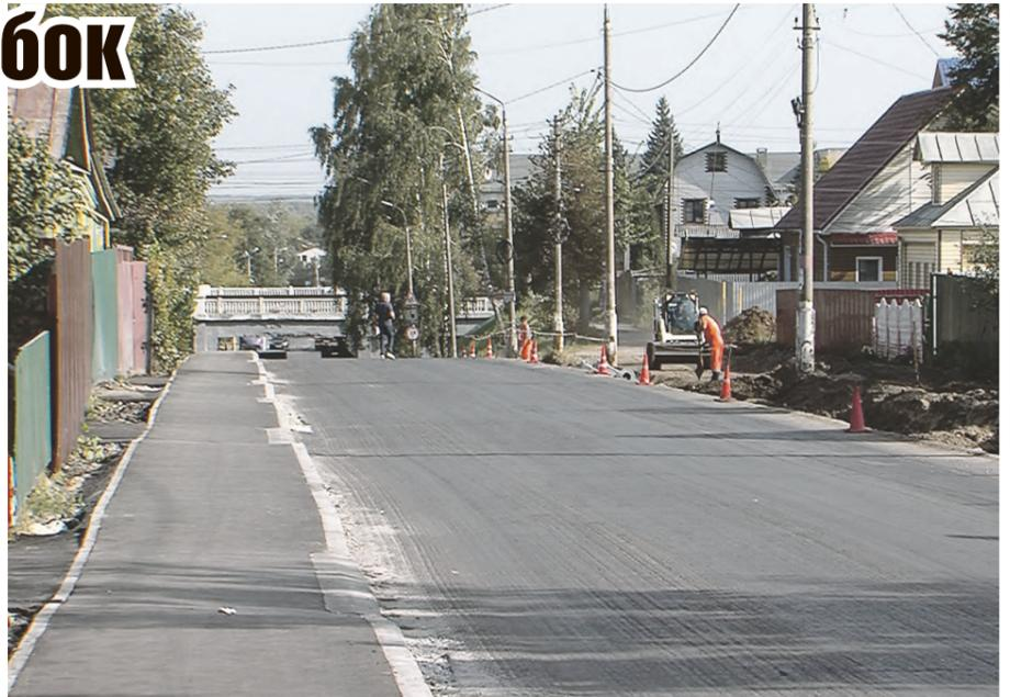
идёт полным ходом с 28 августа. Подрядчик уже выполнил заметный объём работ. Отфрезеровано шоссе, то есть с него снят старый асфальт на участке протяжённостью 130 метров. Сразу же был построен один из тротуаров, чтобы свести к минимуму неудобства для пешеходов. Согласно проекту, тротуары теперь будут шириной полтора метра, что заметно больше, чем прежде, а ширина проезжей части из трёх полос составит девять метров. Кстати, о новой разметке:
