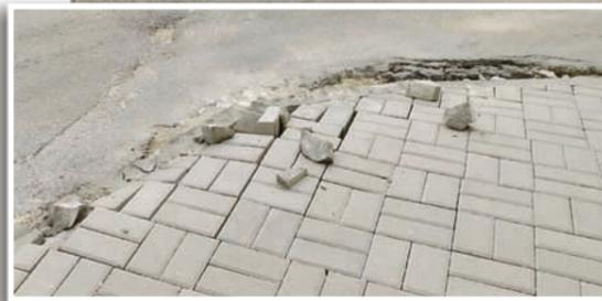
новеньких тротуаров по проезжей части тянутся неряшливые выбоины, забитые пылью, мусором и строительными отходами. Если оставить это всё как есть, то и новый бортовой камень долго не простоит, и ускоренная «коррозия» всего дорожного полотна просто обеспечена. Именно поэтому бордюры обычно меняют в процессе ремонта всего дорожного покрытия. Такие
