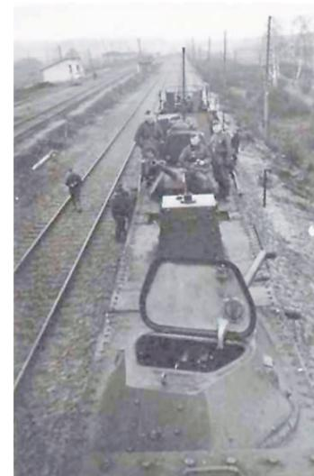
Уцелевшая после боя часть бронепоезда № 1 «За Сталина». За бронеплощадкой хорошо просматривается вагон ПВО с 37-мм автоматической зенитной пушкой.
