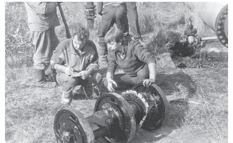
В. В. Кондратьев справа. Осмотр скребка-калибра на ЛПДС «Мозырь» после пропуска по нефтепроводу Речица – Мозырь (Беларусь). Сентябрь 1991 г.
