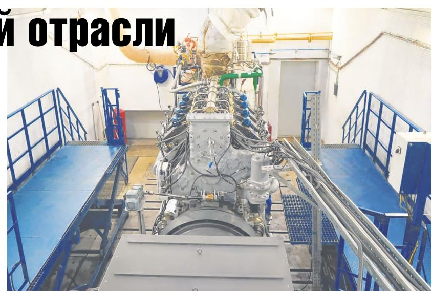
две газопоршневые электростанции ЭГПК-9 на базе двигателей 1-9ГМГ, установленные на территории предприятия.
